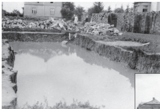
Místo sborového domu bazén: práce na sklepech a základech přerušily povodně
